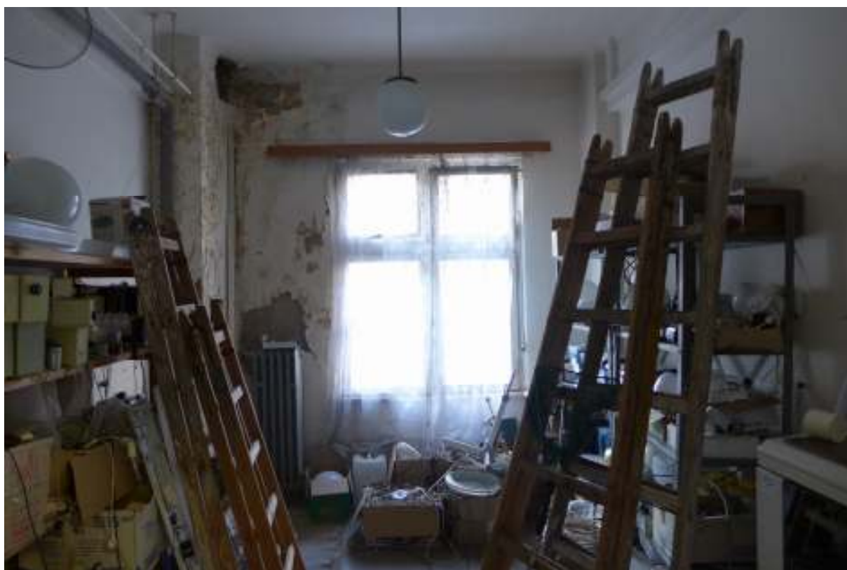
Stena poškodená vodou.
